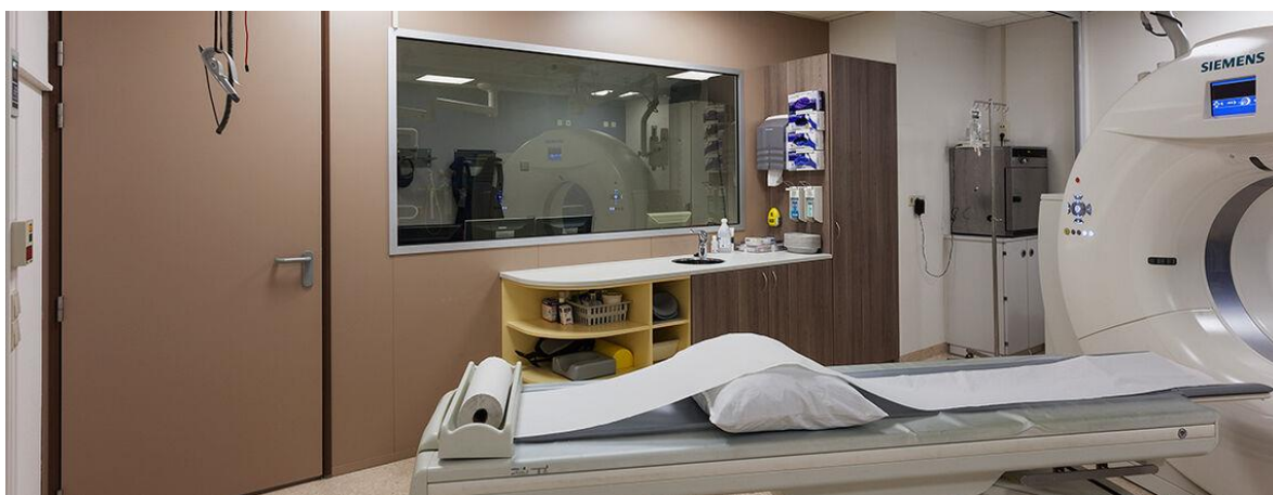
Figuur 20: Een CT-scanner met een loodwand (de bruine wand met een deur en raam). De loodwand beschermt de artsen en laboranten tegen de ioniserende straling van de CT-scan. Ook in het glas zit lood, op deze manier kunnen de artsen op een veilige manier naar de ruimte met de CT-scanner kijken.
