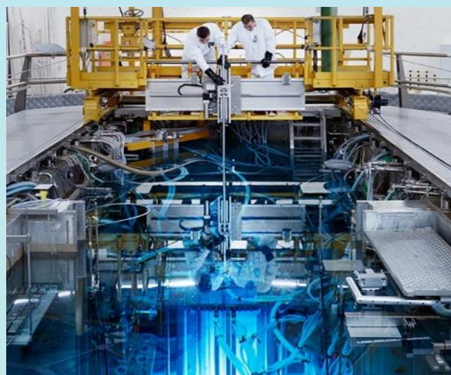
Figuur 4: Het HFR-reactorbasin met de typische blauwe gloed van de kern (door het Tscherenkov-effect) in het water. Bron: nrg.eu
